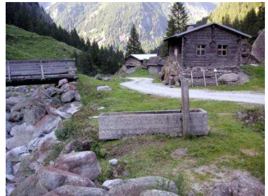
Rachhütten bei km 20,6
